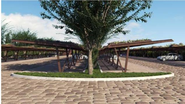
Il parcheggio sarà totalmente drenante, si prevede una pavimentazione per le aree di manovra e movimentazione in masselli in Cls autobloccanti denominati “Gransasso” prodotti da Tegolaia, progettati per gli ecopark, di colorazione mista brunita tipo trachite. Per gli stalli si prevede una betonella omogenea autobloccante filtrante, denominata “Farnese” in quattro formati, in colorazione porfido.
