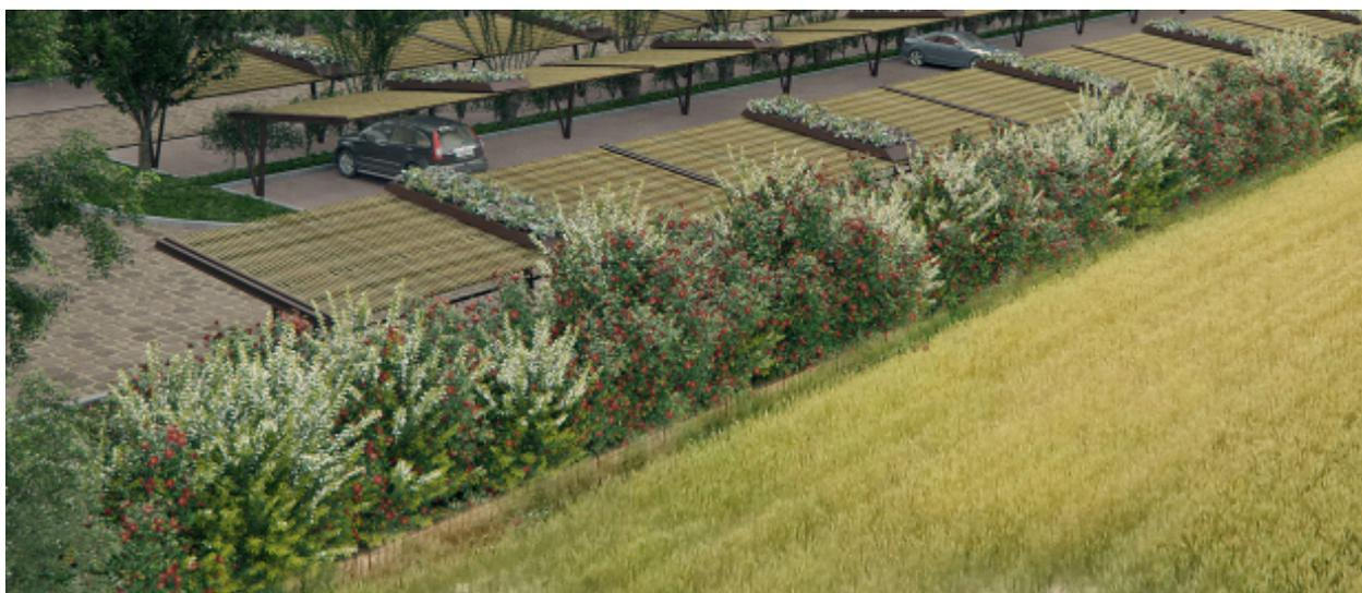
Il parcheggio sarà totalmente coperto con una struttura metallica a sbalzo con canne di bamboo di grande dimensione, alternate a vasche di verde pensile estensivo, ogni quattro posti auto cosicché la percezione dall'alto sia molto mitigata. Al centro delle stecche di posti auto a pettine sono previste tre un'aiuole con un filare di Aceri Campestri 'Elsrijk', piccolo albero tipico della campagna veneta a portamento compatto globoso, fogliame caduco verde e
